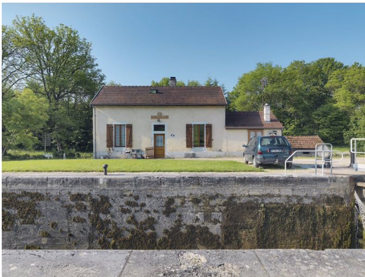
La maison éclusière de face.
