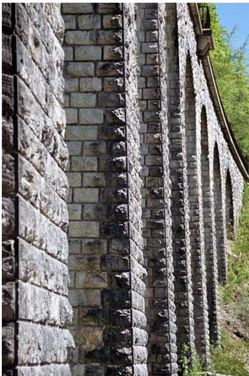
Viaduc du Puits : piles vues en enfilade.
