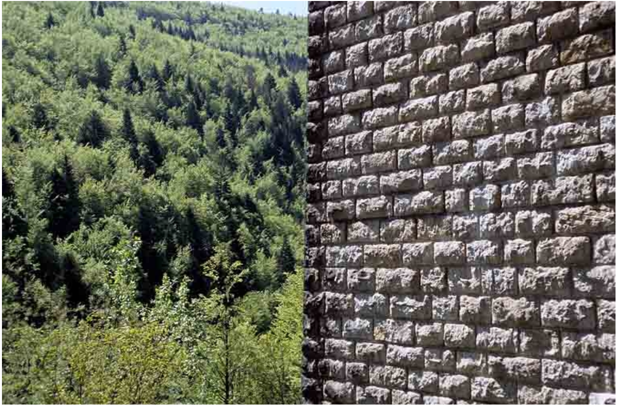
Viaduc du Puits : parement d'une pile.
