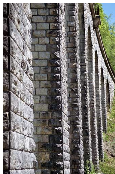
Viaduc du Puits : piles vues en enfilade. Phot. Yves Sancey IVR43_20053900612ZA
