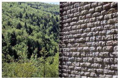
Viaduc du Puits : parement d'une pile.
