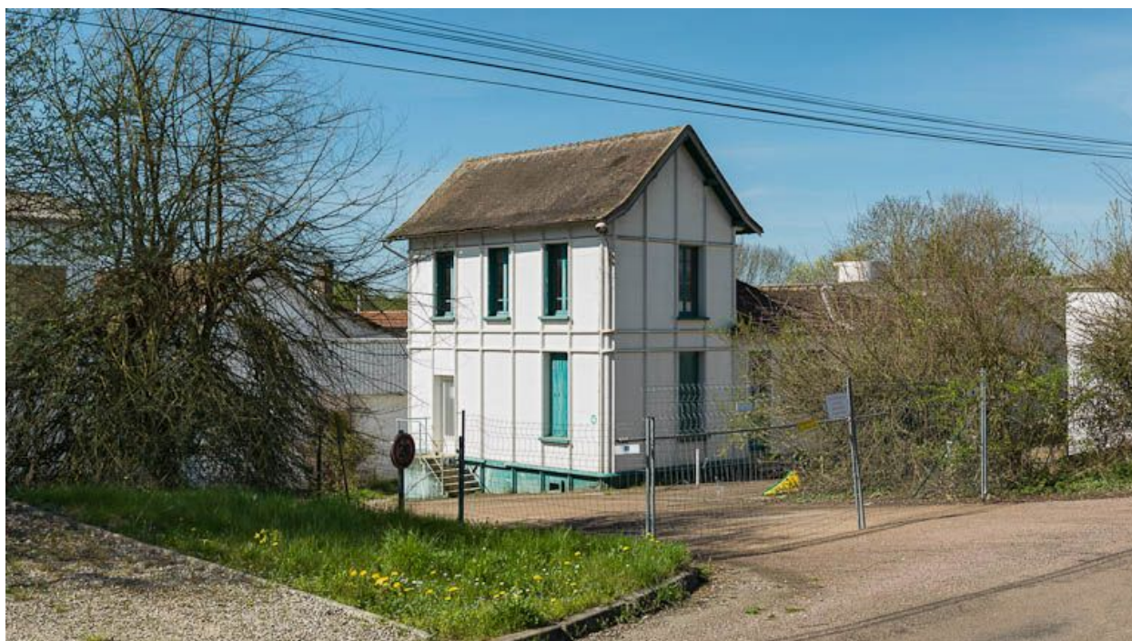
Détail d'un bâtiment de l'entre-deux-guerres.
