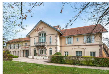
Façade nord-ouest. Phot. Jérôme Mongreville IVR43_20227000152NUC4A
