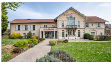
Façade nord-ouest. Phot. Jérôme Mongreville IVR43_20227000151NUC4A
