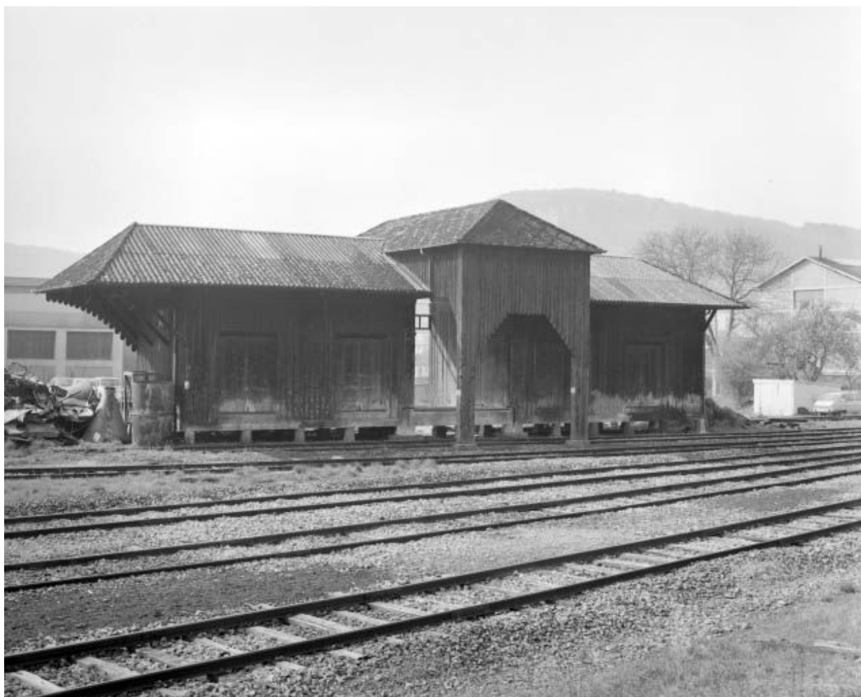
Ornans, façade postérieure de la gare de marchandises.
