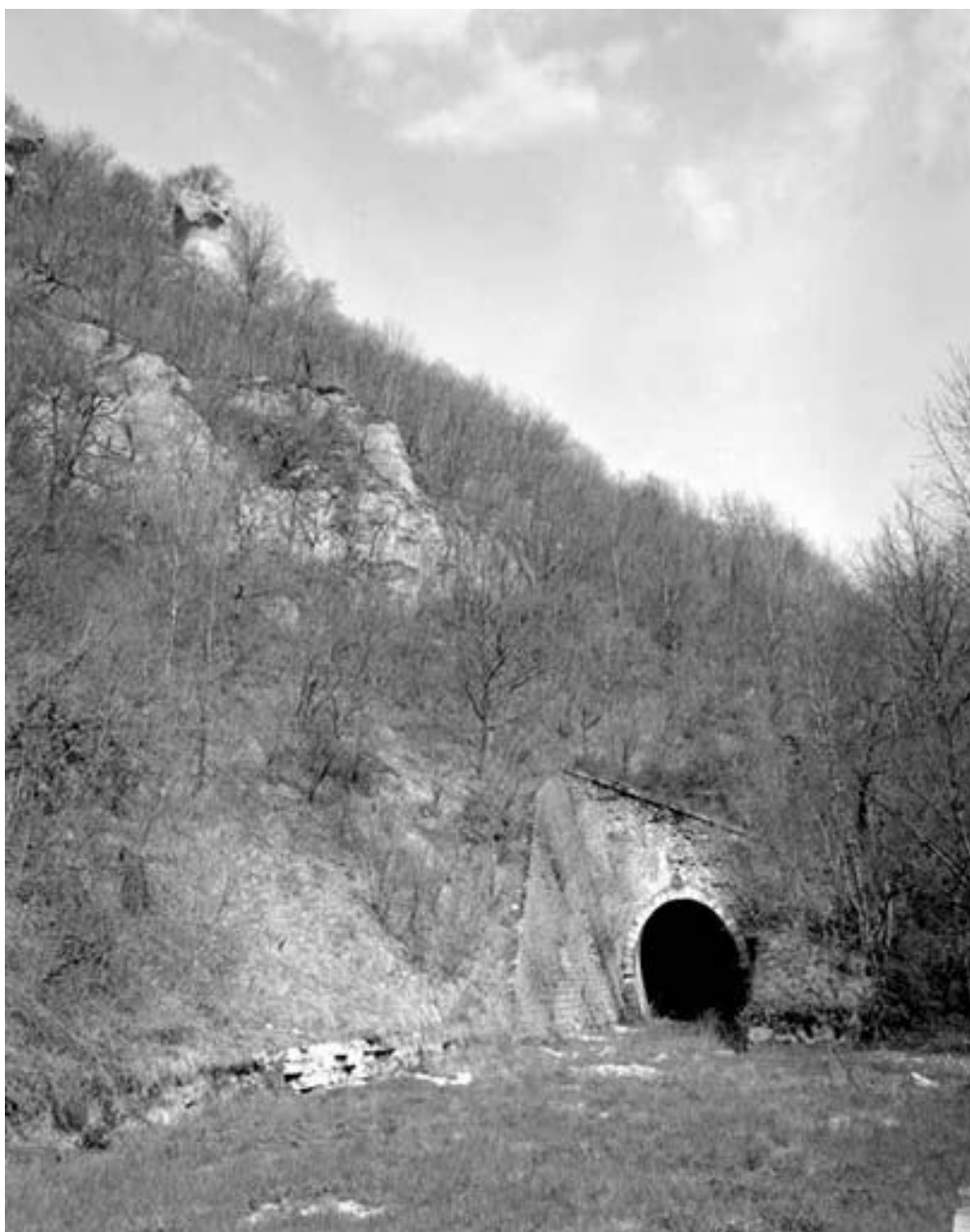
Bonnevaux-le-Prieuré : le tunnel.
