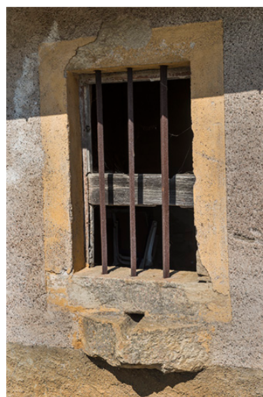
La fenêtre de la cuisine. Phot. Jérôme Mongreville IVR43_20177001211NUC4A
