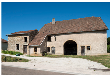
vue d'ensemble. Phot. Jérôme Mongreville IVR43_20177001214NUC4A
