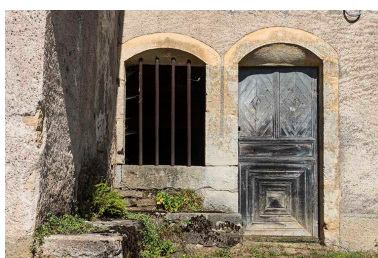
Détail sur les ouvertures avec leurs arcs segmentaires délardés. Phot. Jérôme Mongreville IVR43_20177001212NUC4A
