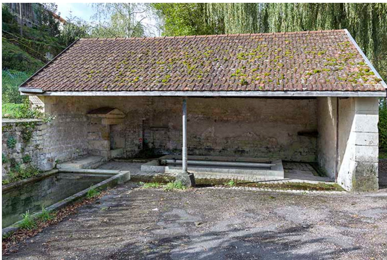
Vue générale de la fontaine-lavoir.
