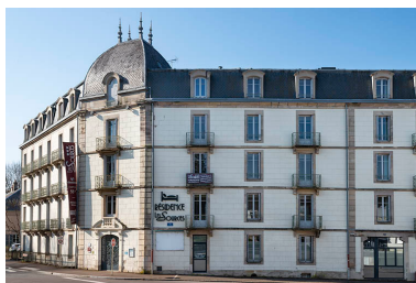
Façade sur rue de l'aile nord, détail. Phot. Jérôme Mongreville IVR43_20227000060NUC4A
