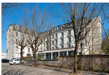
Vue d'ensemble, côté parc. Phot. Jérôme Mongreville IVR43_20227000067NUC4A
