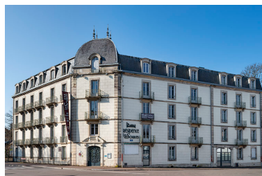
Vue d'ensemble, côté rue. Phot. Jérôme Mongreville IVR43_20227000058NUC4A
