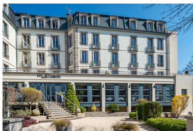
Façade sur parc de l'aile sud. Phot. Jérôme Mongreville IVR43_20227000068NUC4A
