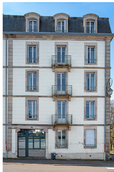
Façade sur rue de l'aile nord, détail. Phot. Jérôme Mongreville IVR43_20227000059NUC4A
