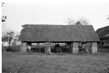
Halle de séchage (D). Phot. Laurent Poupard
