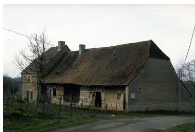
Etable et logement patronal, depuis l'est. Phot. Laurent Poupard IVR43_19893901175Z
