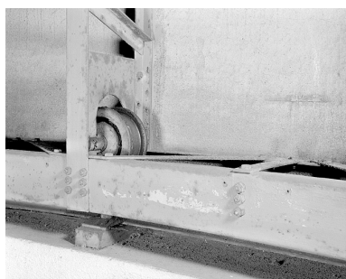
Système de rotation de la coupole : galet. Phot. Jérôme Mongreville IVR43_20032501085X
