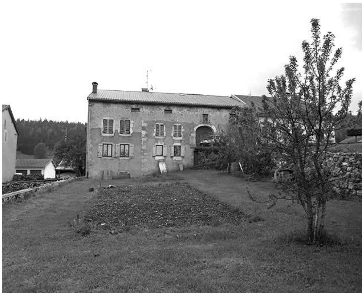
Façade postérieure, vue éloignée.
