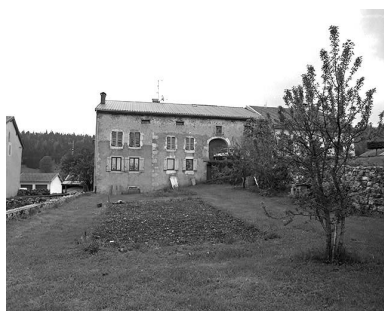
Façade postérieure, vue éloignée.
