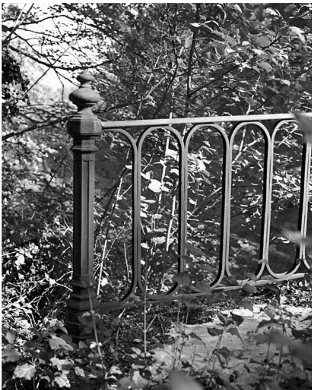
Garde-corps : détail d'un potelet.
