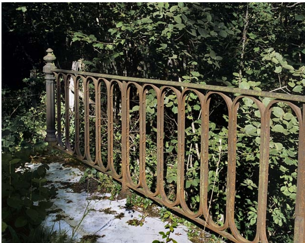
Détail d'un garde-corps.
