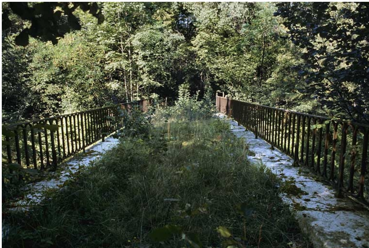
Tablier, depuis l'extrémité ouest.
