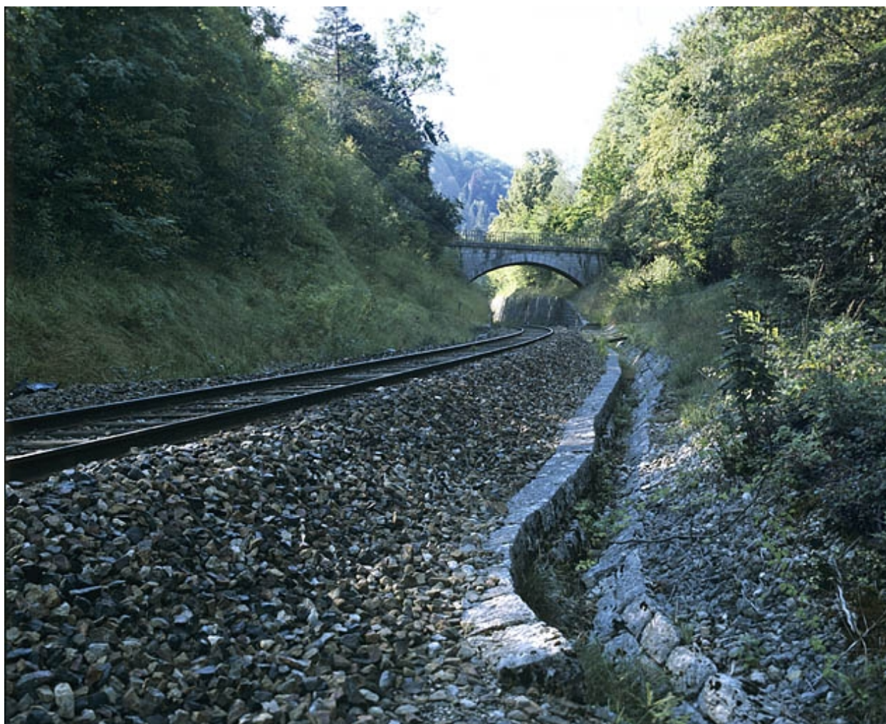
Vue d'ensemble, depuis le côté Andelot-en-Montagne (nord).
