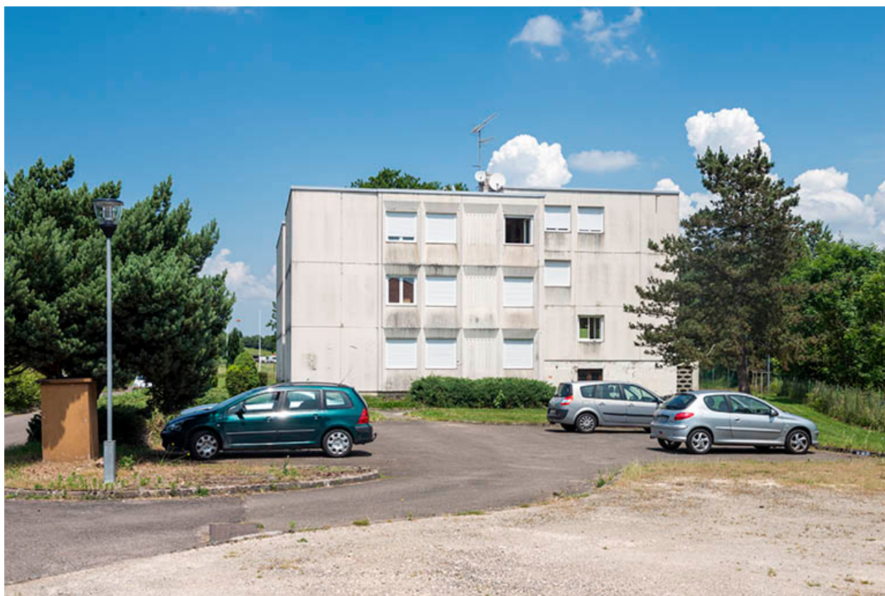
Façade sud des logements.
