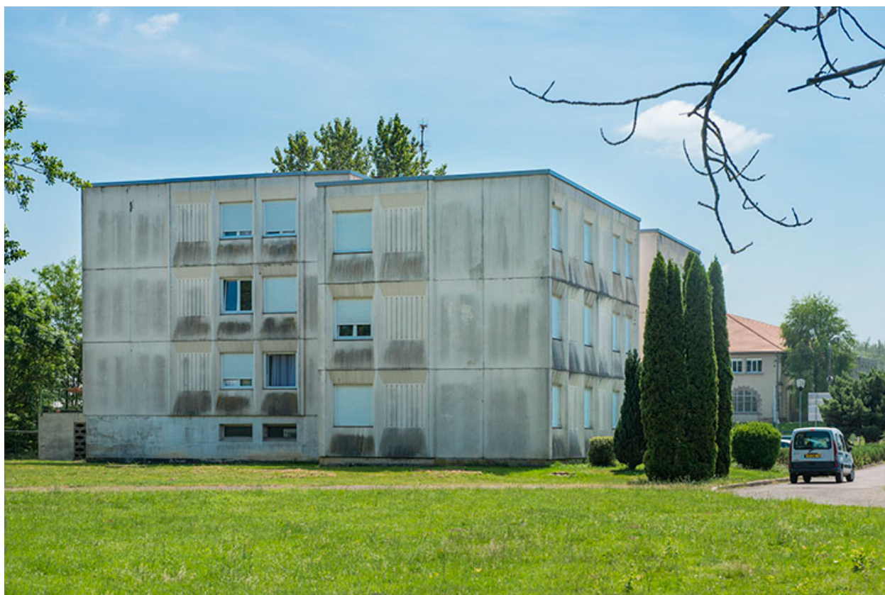
Angle nord-ouest des logements de fonction.
