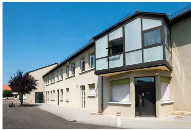
Angle sud-ouest à l'entrée de la cour. Phot. Mary Ruffinoni IVR43_20147000107NUC4A
