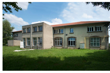
Façade ouest de l'externat atelier. Phot. Mary Ruffinoni IVR43_20147000127NUC4A
