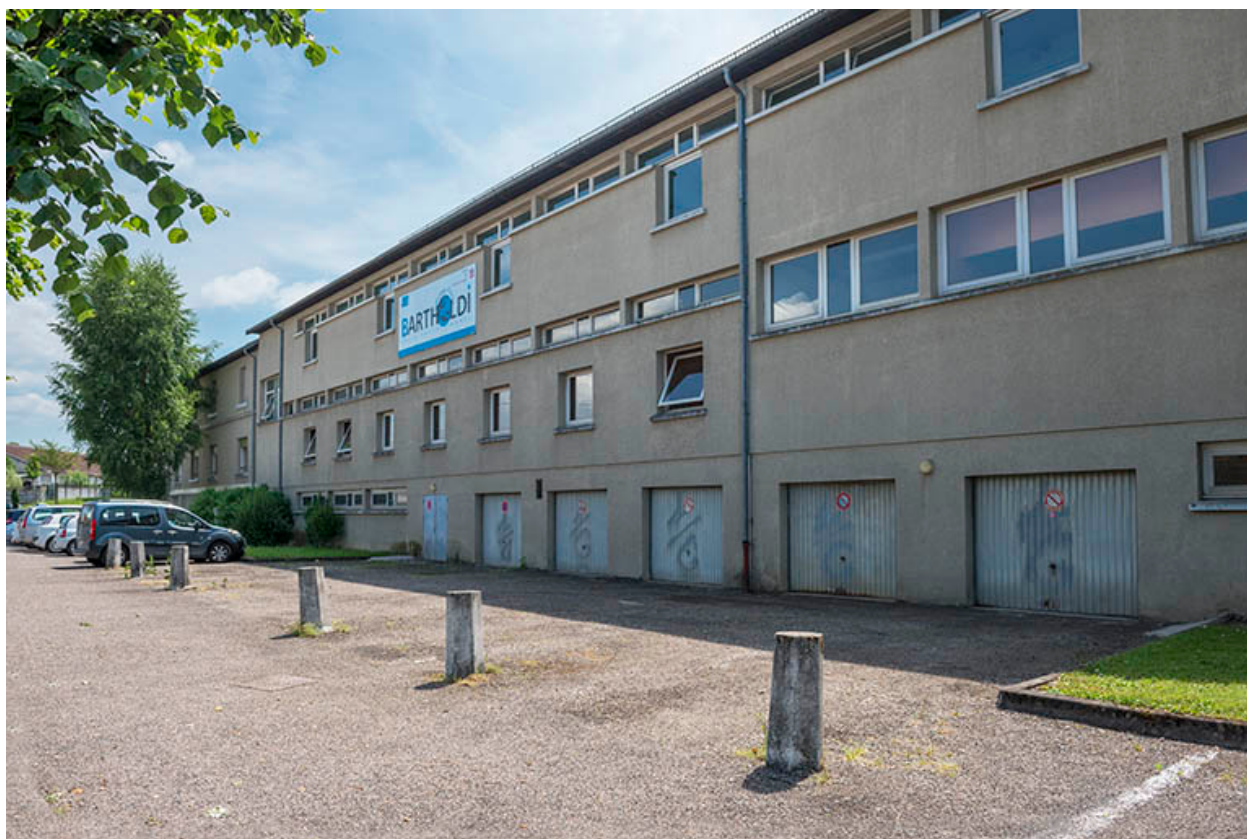
Façade nord rue de Bourdieu.
