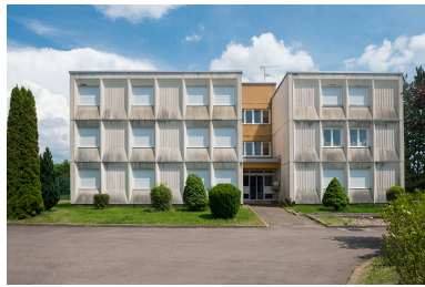
Façade ouest d'entrée des logements de fonction. Phot. Mary Ruffinoni IVR43_20147000123NUC4A
