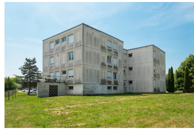
Angle nord-est des logements de fonction. Phot. Mary Ruffinoni IVR43_20147000119NUC4A
