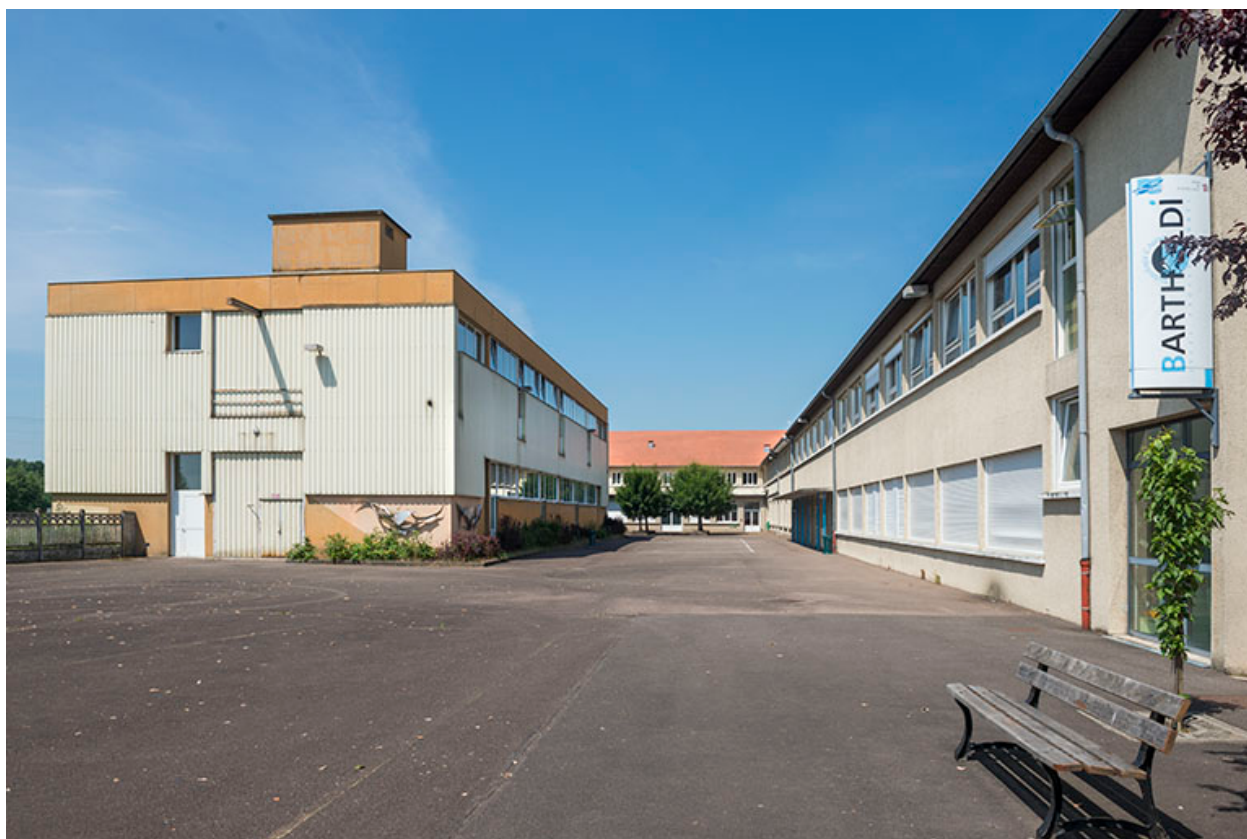
Vue de l'entrée depuis l'est.
