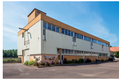
Angle nord-est de l'atelier. Phot. Mary Ruffinoni IVR43_20147000104NUC4A
