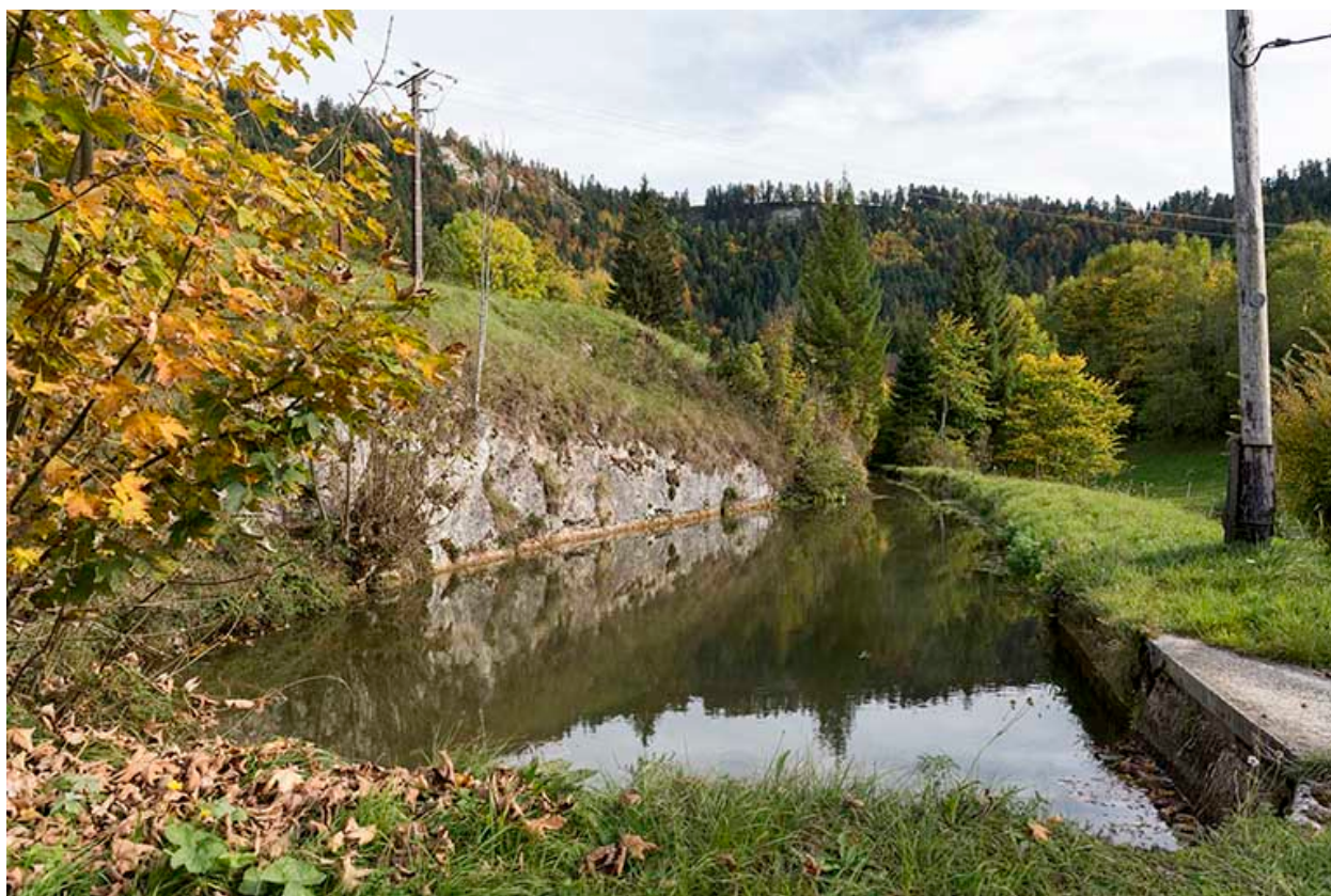
Bassin de retenue.
