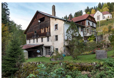
Bâtiment depuis le cours d'eau, au sud. Phot. Sonia Dourlot IVR43_20172501776NUC4A
