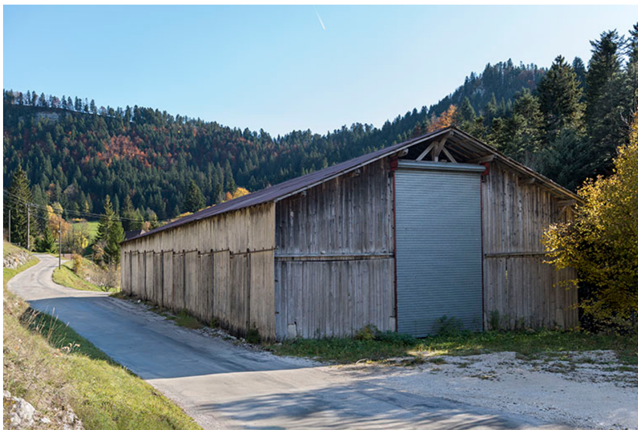
Hangar, au nord.
