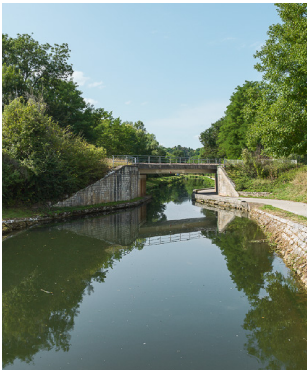
Vue d'ensemble du pont.
