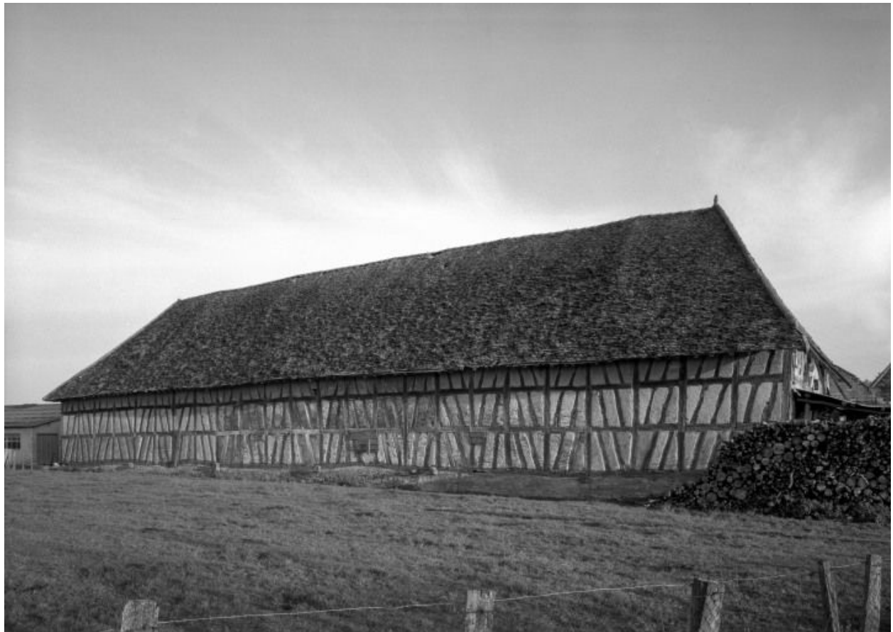
Bâtiment des dépendances, façade postérieure
