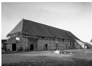
Bâtiment des dépendances, façade antérieure Phot. Michel Rosso IVR26_19867100226V
