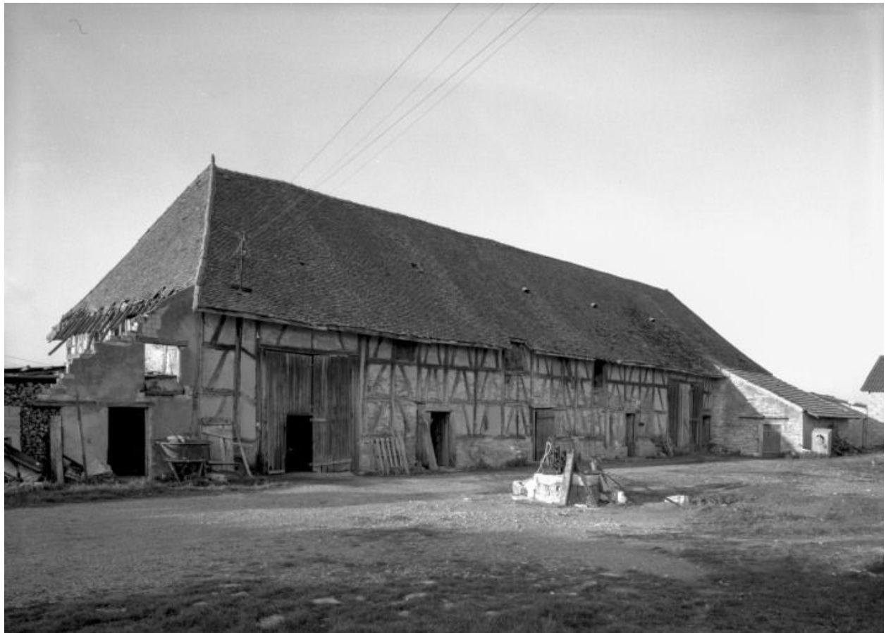
Bâtiment des dépendances, façade antérieure
