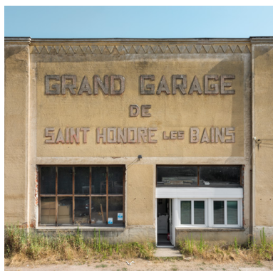
Travée centrale de la façade. Phot. Pierre-Marie Barbe-Richaud IVR26_20195800512NUC2A
