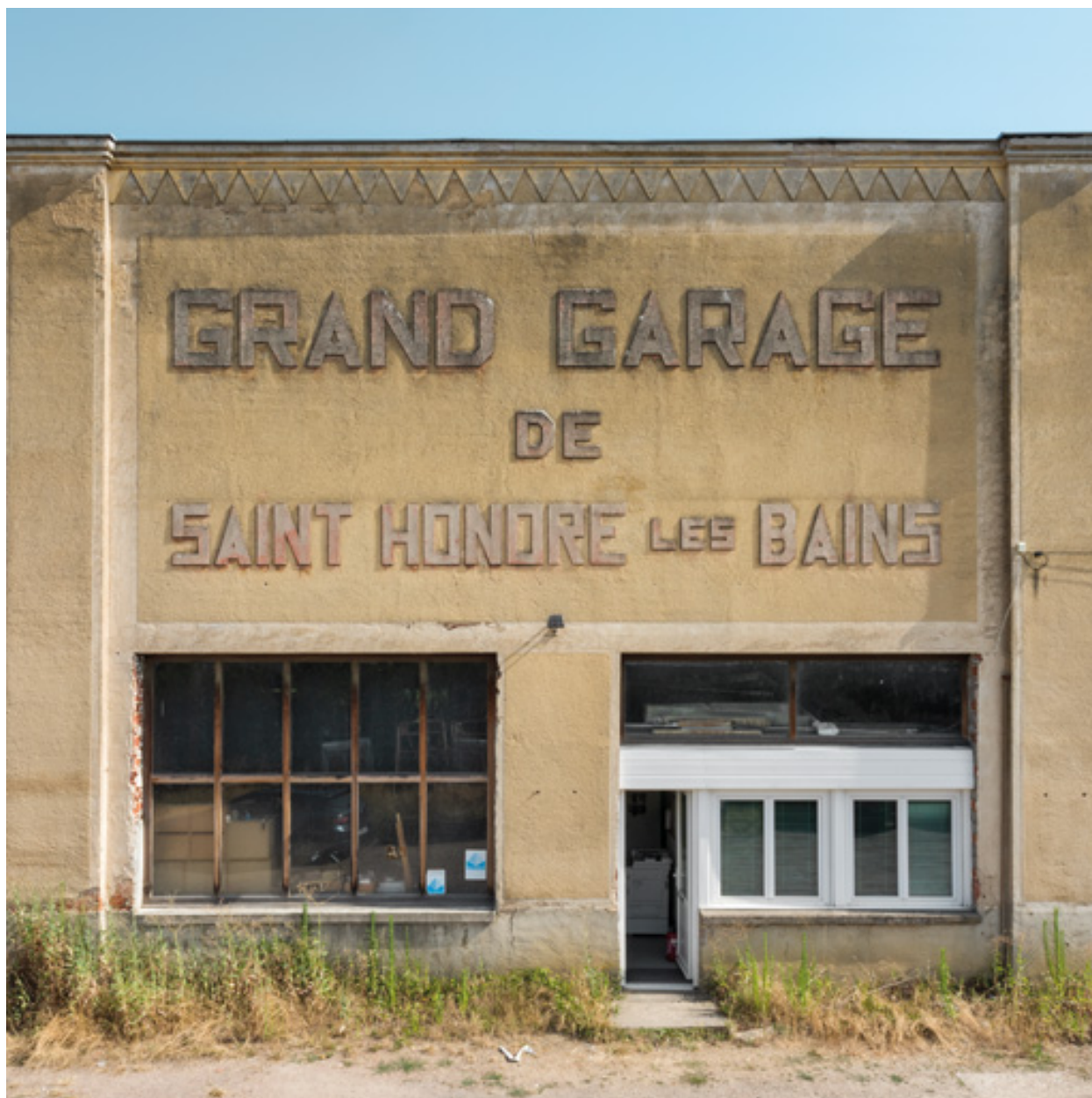
Travée centrale de la façade.
