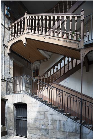
Vue d'ensemble de l'escalier à cage ouverte de trois quarts droit. Phot. Jérôme Mongreville IVR43_20112500052NUC4A
