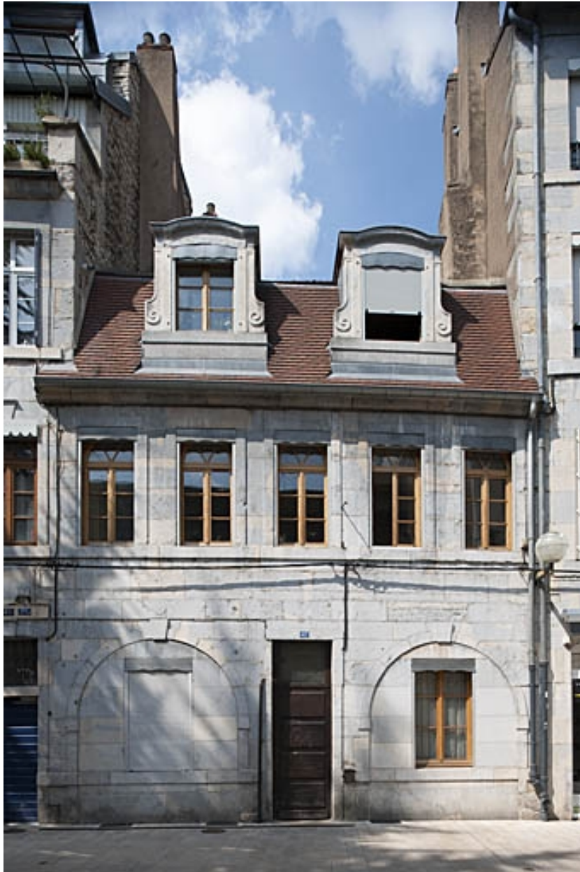
Façade antérieure : vue d'ensemble de face.
