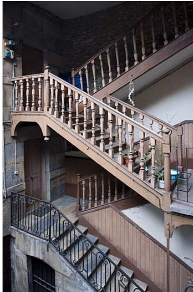
Détail de l'escalier à cage ouverte de trois quarts droit. Phot. Jérôme Mongreville IVR43_20112500054NUC4A
