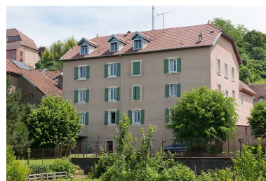
Façade postérieure. Phot. Jérôme Mongreville IVR43_20102500657NUC4A
