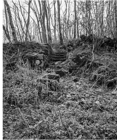
Détail des vestiges depuis le nord. Phot. Jérôme Mongreville IVR43_19853900154X
