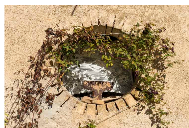
Détail de l'oculus. Phot. Jérôme Mongreville IVR43_20177001200NUC4A
