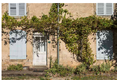
La partie habitation. Phot. Jérôme Mongreville IVR43_20177001201NUC4A
