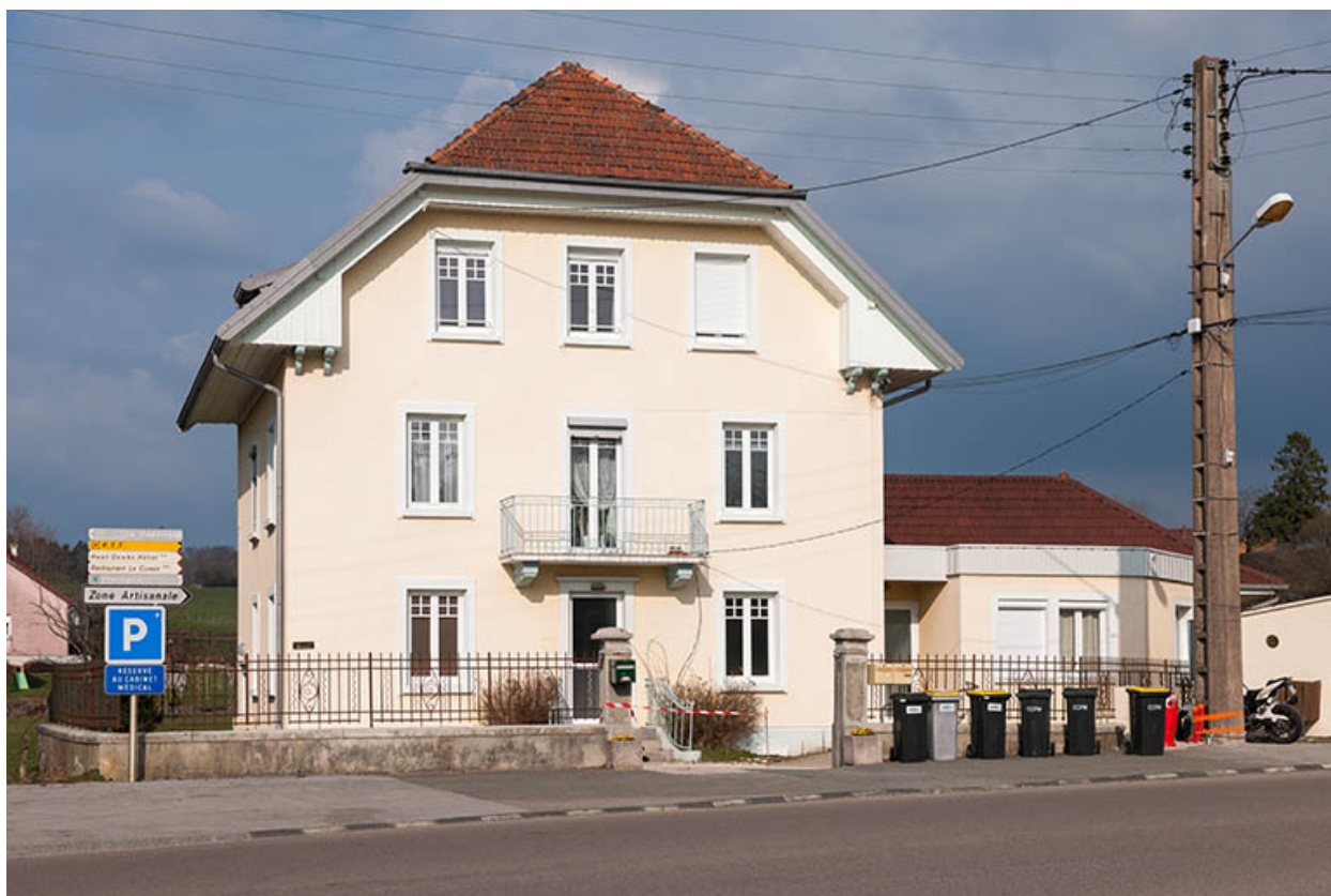
Vue d'ensemble, depuis l'ouest (façade antérieure).
