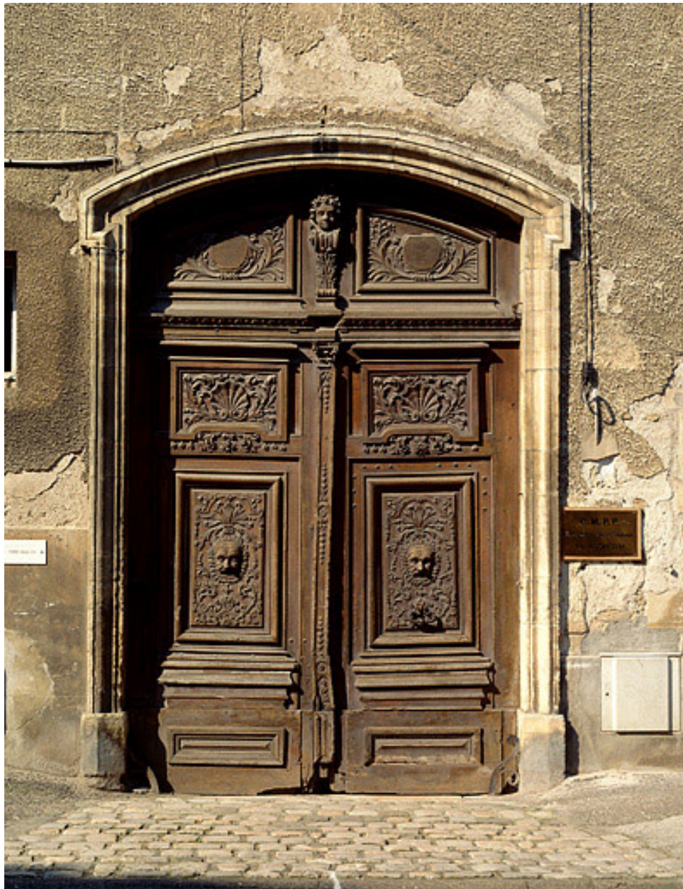
Détail de la porte d'entrée.
