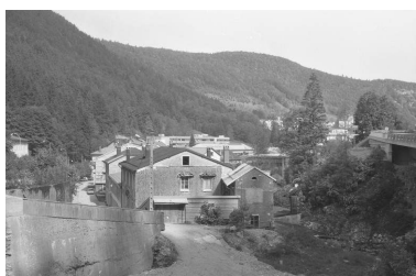
Vue d'ensemble depuis le sud (amont). Phot. Laurent Poupard IVR43_19913901327Z
