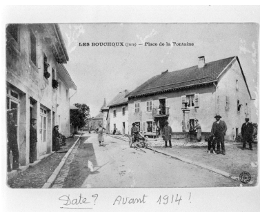
Place de la Fontaine. Phot. Jérôme Mongreville IVR43_19943901177X
