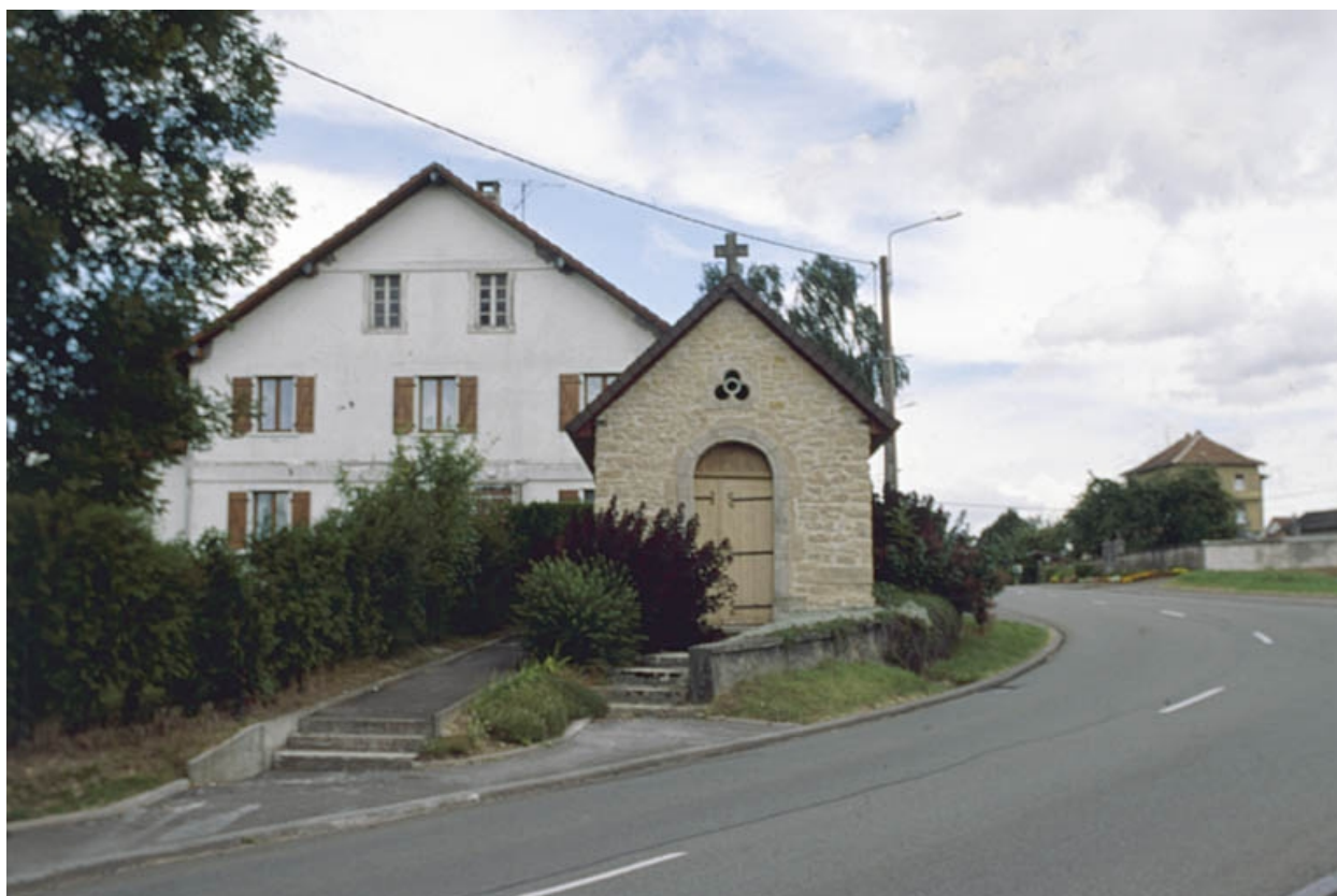
Mur-pignon sud du bâtiment : le logement.
