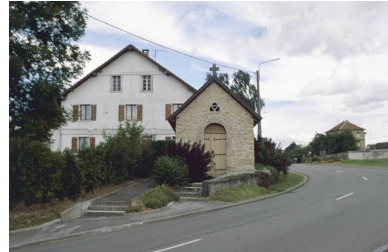
Mur-pignon sud du bâtiment : le logement. Phot. Yves Sancey IVR43_20019000363ZA
