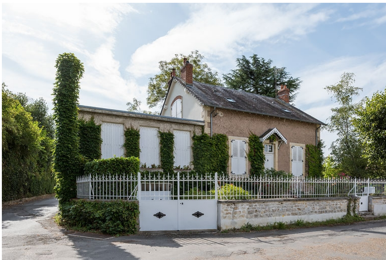
Vue de trois quarts depuis le nord.
