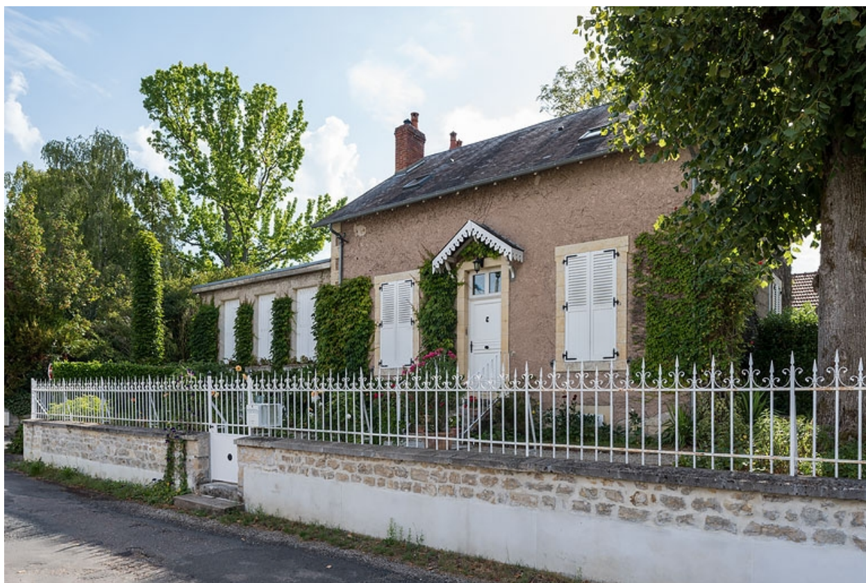
Vue de trois quarts depuis l'ouest.
