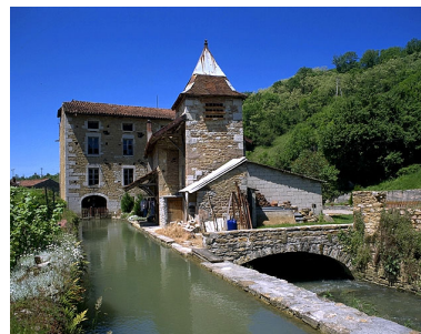
Atelier de fabrication et pigeonnier. Phot. Jérôme Mongreville IVR43_19963900410ZA
