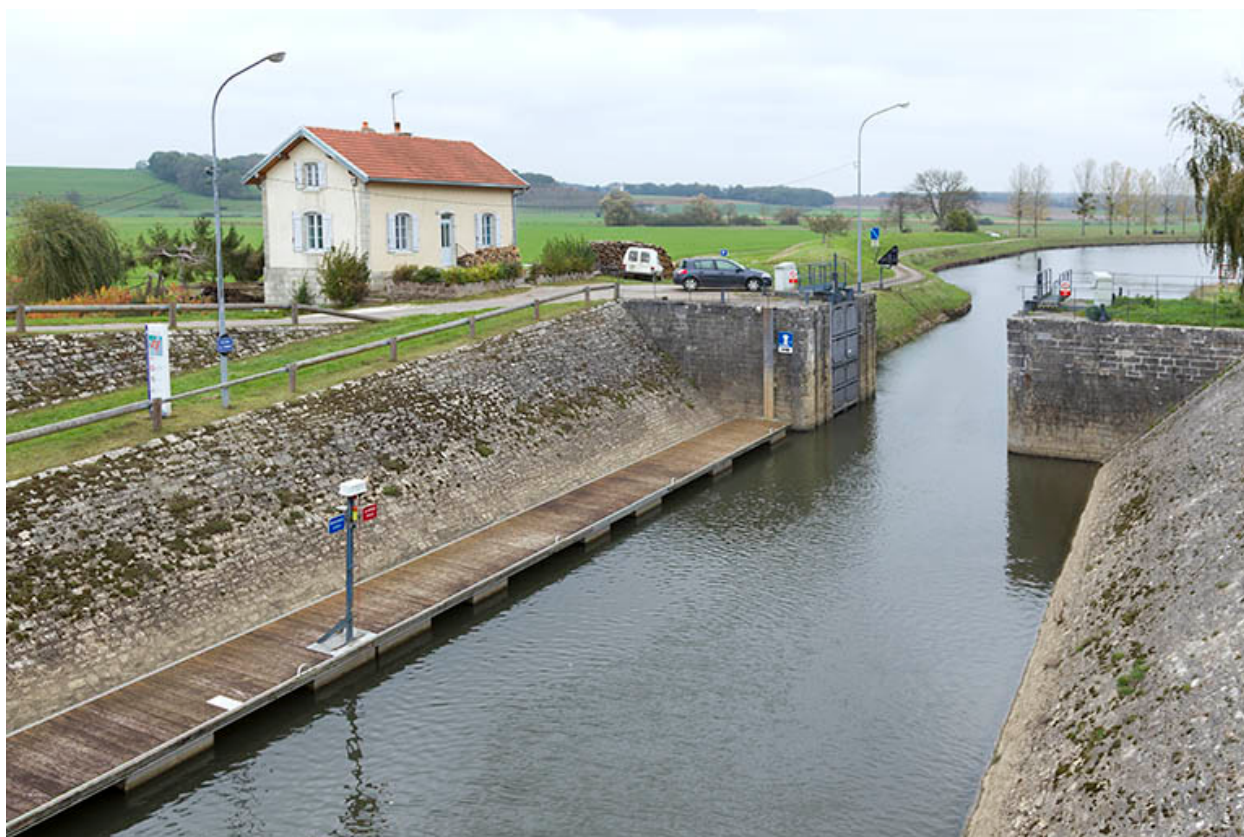
Les perrés inclinés de l'écluse de garde.
