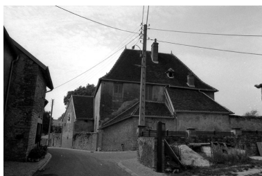
Demeure située rue de Pampouille. Phot. Bernard Lardière IVR43_19797000011Z
