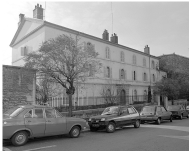
Vue d'ensemble. Phot. Yves Sancey IVR43_19833900651X
