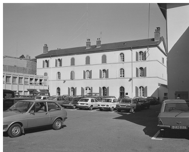
Façade postérieure. Phot. Yves Sancey IVR43_19833900517X
