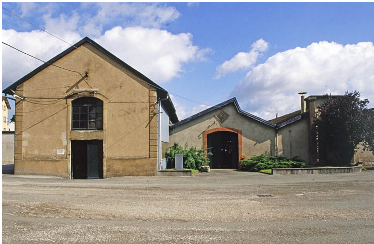
Murs-pignons des ateliers de fabrication.
