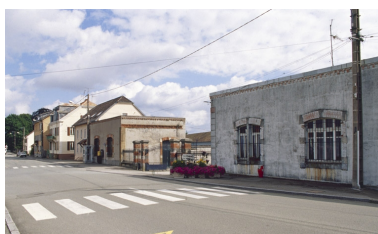
Bâtiments d'entrée depuis la rue du Général Leclerc. Phot. Yves Sancey IVR43_20009000045ZA
