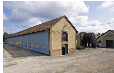
Atelier de fabrication (câblerie). Phot. Yves Sancey IVR43_20009000061ZA
