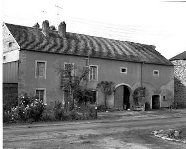
Ferme située route d'Oiselay. Phot. Dominique Dominguez IVR43_19807000160X
