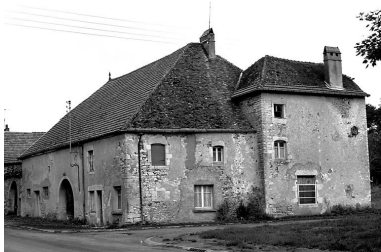
Ferme située route d'Oiselay. Phot. Dominique Dominguez IVR43_19807000158X
