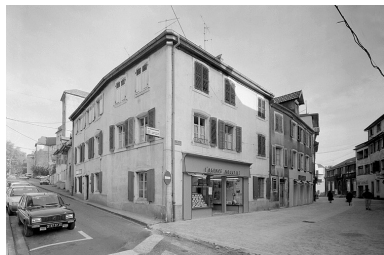
Vue d'ensemble. Phot. Jérôme Mongreville IVR43_19872501166V
