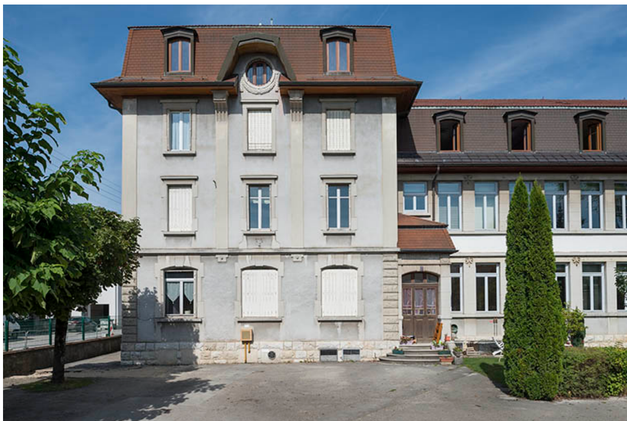
Pavillon ouest : bureau et logements.
