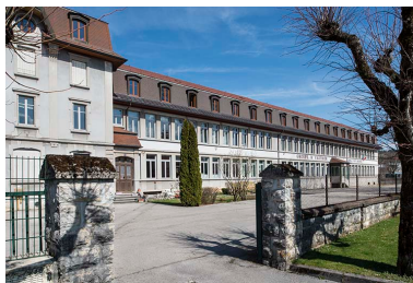
Façade sud vue de trois quarts gauche. Phot. Jérôme Mongreville IVR43_20172500317NUC4A
