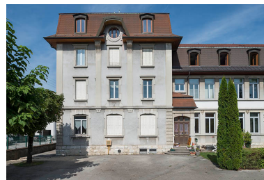
Pavillon ouest : bureau et logements. Phot. Jérôme Mongreville IVR43_20162501177NUC4A
