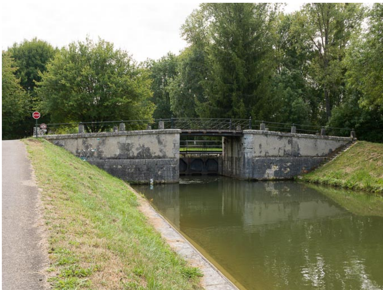
Vue d'ensemble du pont.
