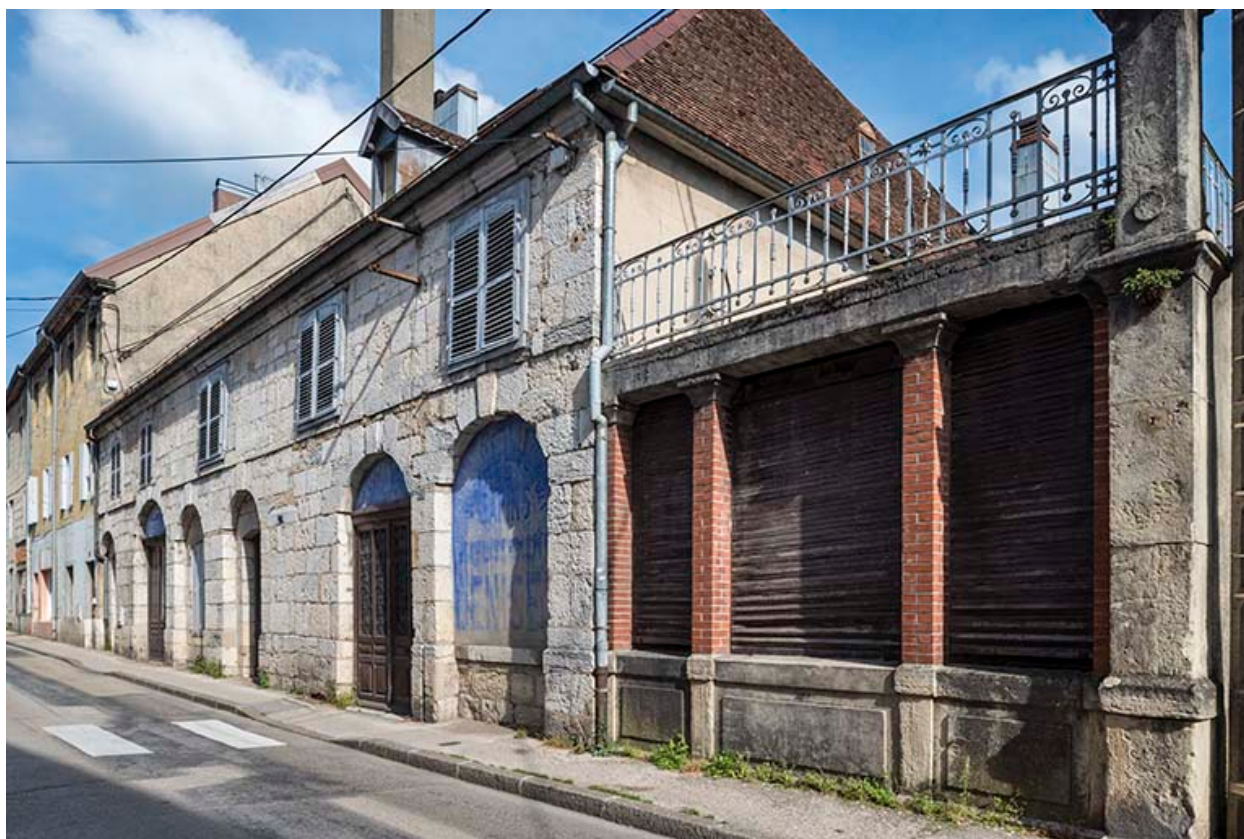
Vue rapprochée depuis le sud-ouest.
