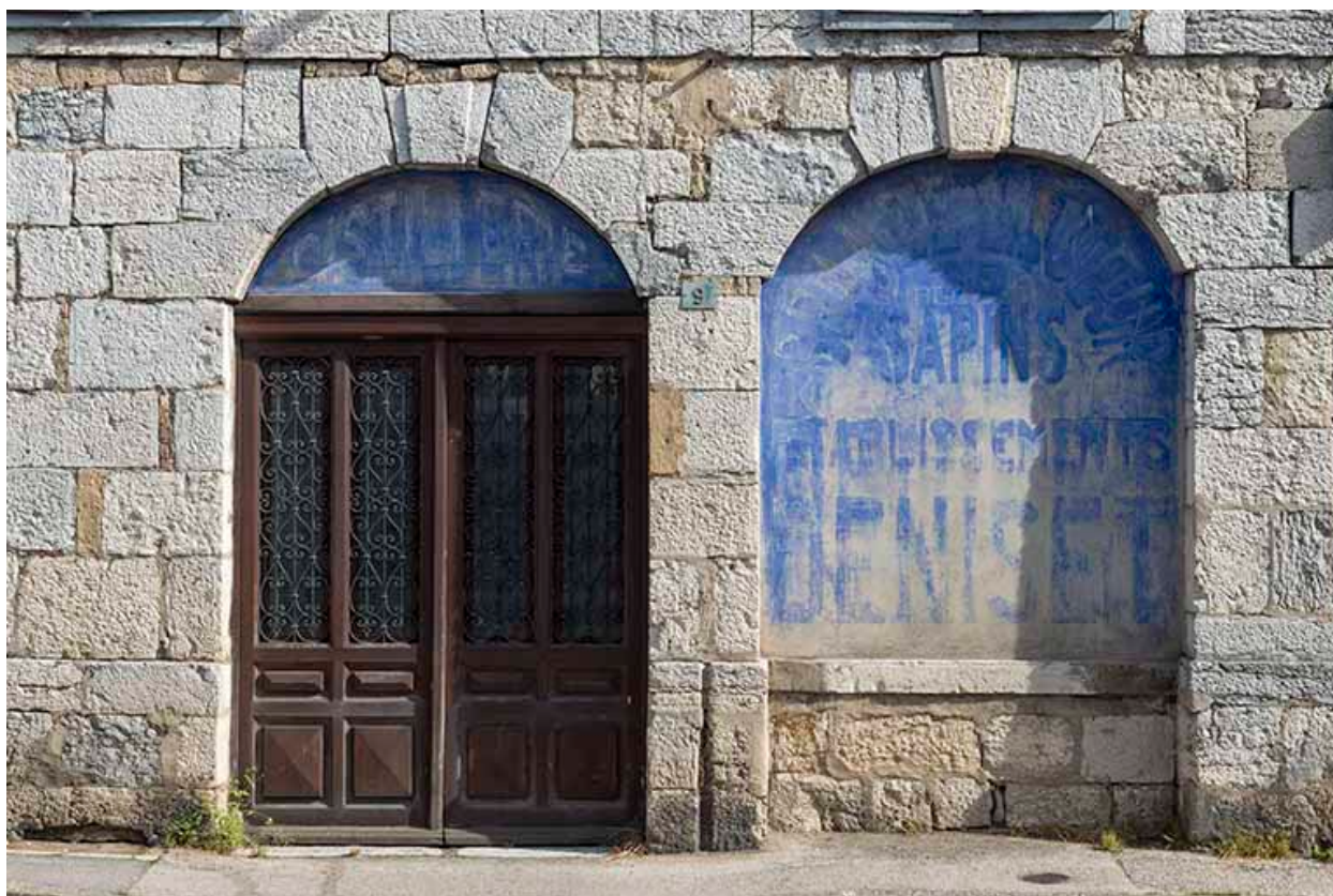
Détail de la façade ouest.
