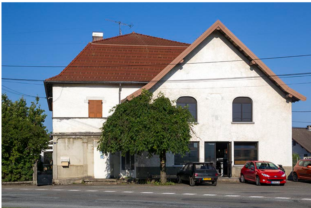
Atelier de fabrication : façade antérieure.
