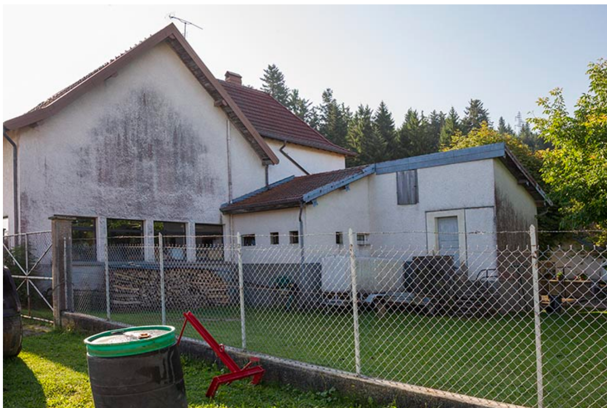
Atelier de fabrication (façade postérieure) et dépendance.
