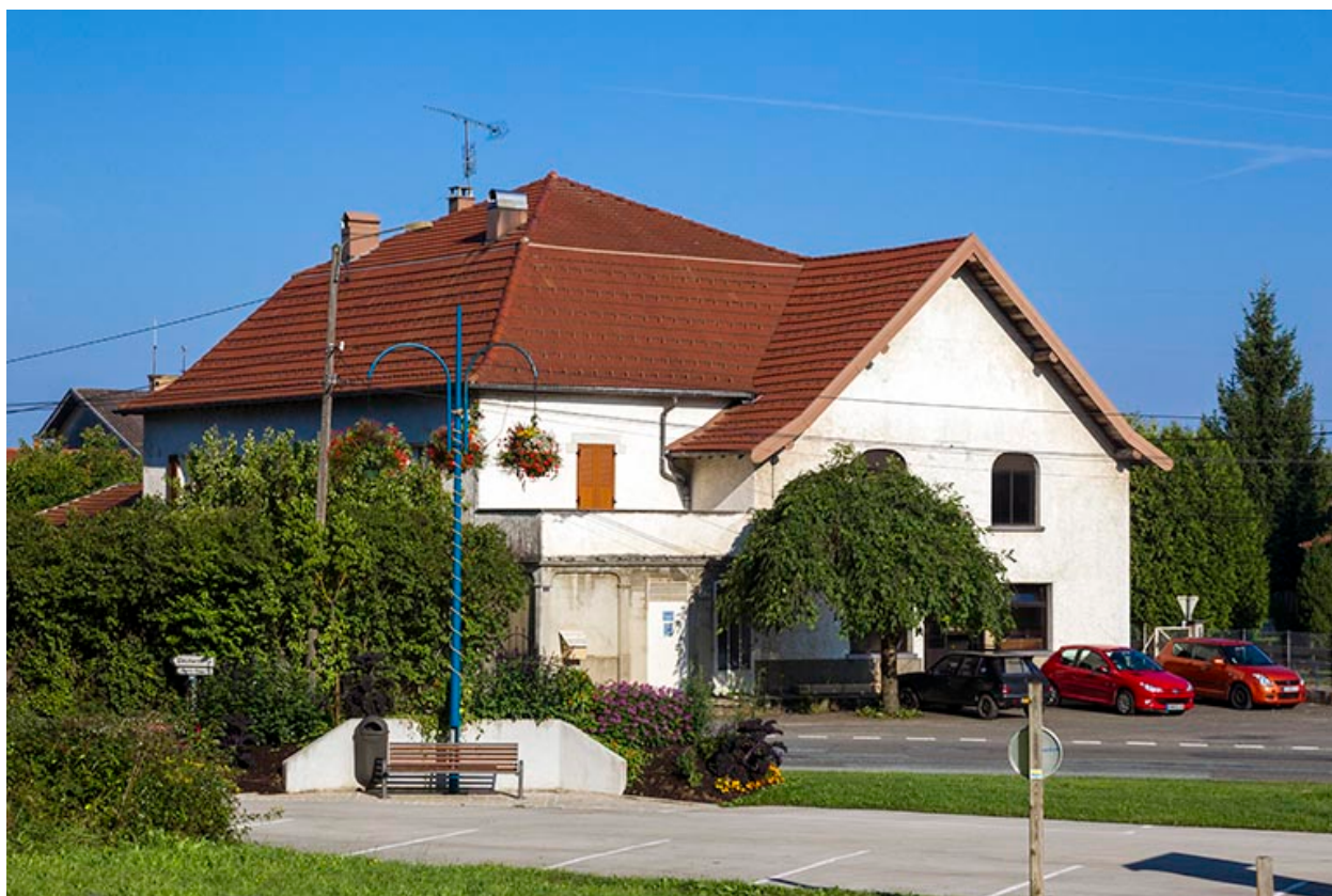
Vue d'ensemble du site, depuis l'est.
