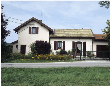
Façade antérieure. Phot. Yves Sancey IVR43_20050100067XA
