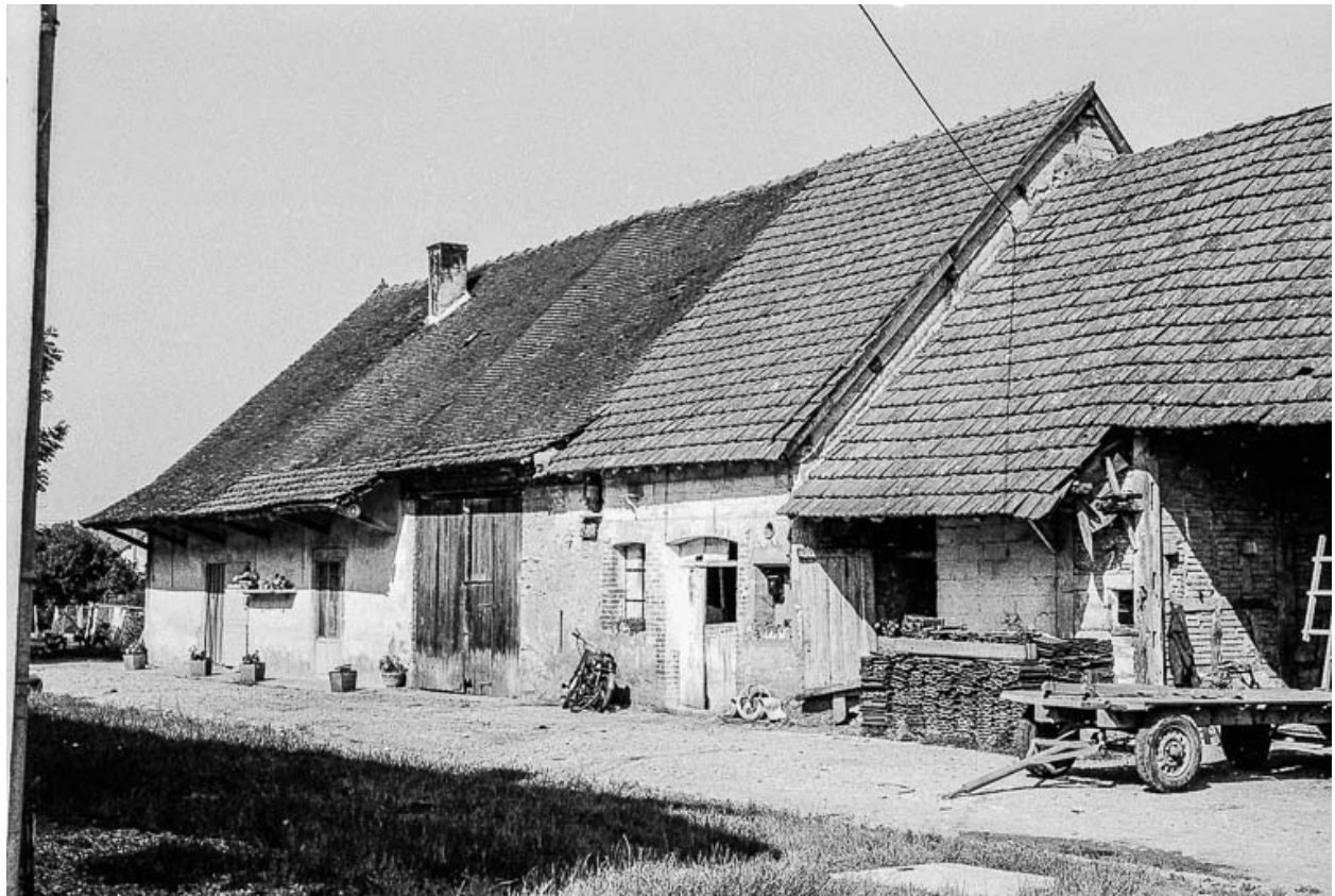
Ferme cadastrée 1984 B 584 : façade antérieure.
