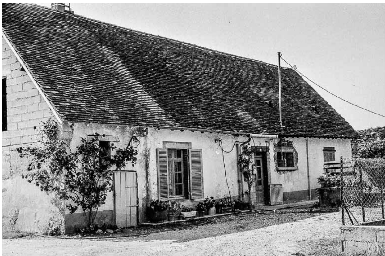
Ferme cadastrée 1984 B 545 : façade antérieure.
