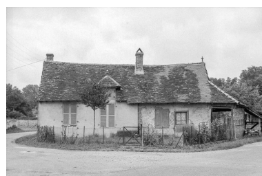
Ferme cadastrée 1984 B 368 : façade antérieure. Phot. Bernard Pontefract IVR43_19753900986Z
