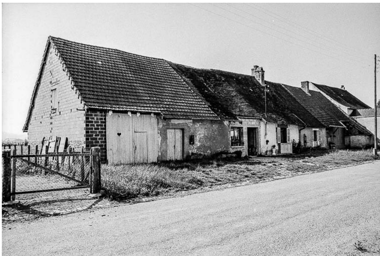
Ferme cadastrée 1984 B2 569-570 : vue d'ensemble.
