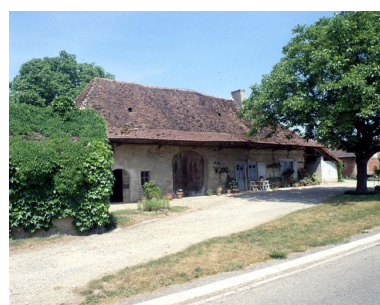
Ferme située Grande Rue : vue d'ensemble. Phot. Yves Sancey IVR43_19903901141XA
