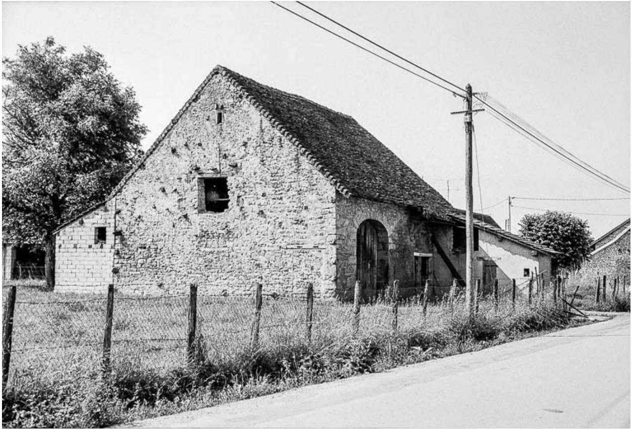
Ferme cadastrée 1984 B 552 : vue d'ensemble.
