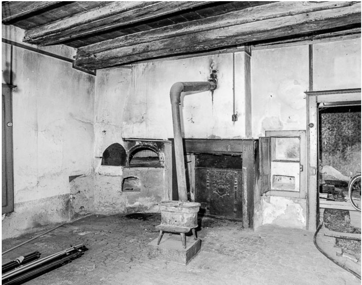
Pièce d'habitation : four, cheminée, cendrier.
