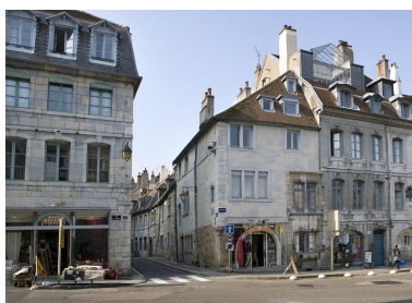
Vue d'ensemble éloignée.
