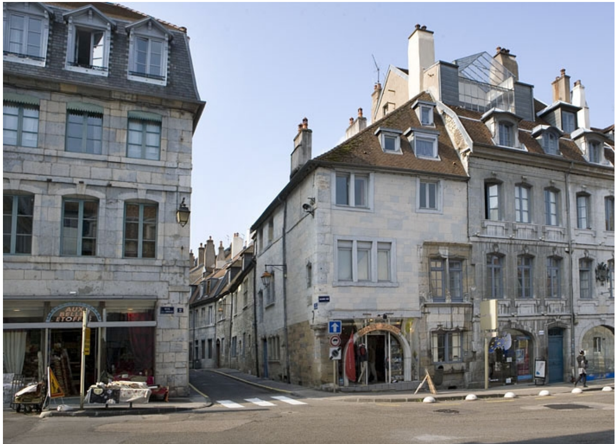
Vue d'ensemble éloignée.
