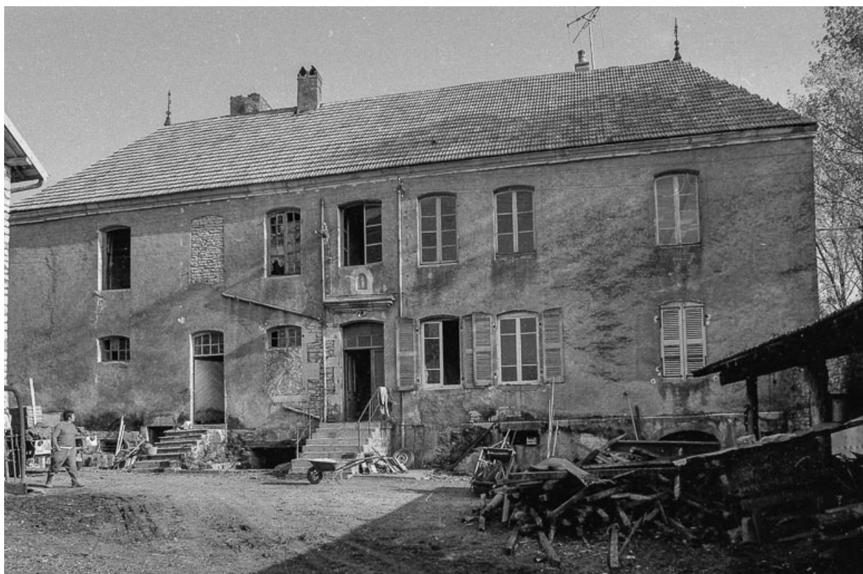
Façade antérieure sur cour.
