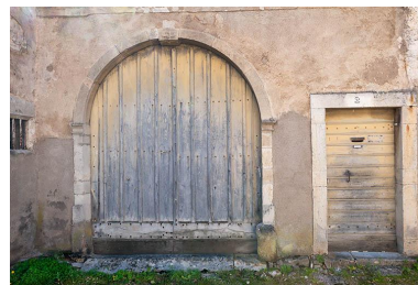
Détail du porche situé rue de l'Eglise Phot. Jérôme Mongreville IVR43_20137000344NUCA
