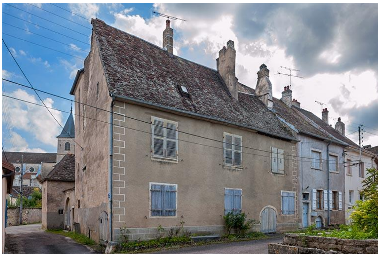
Vue générale nord-est
