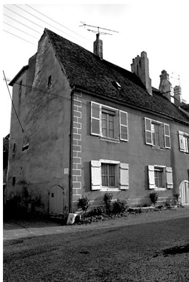
Façade antérieure. Phot. Dominique Dominguez IVR43_19807000550X
