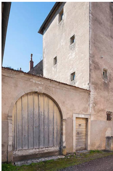
Vue du porche d'entrée dans la cour Phot. Jérôme Mongreville IVR43_20137000345NUCA
