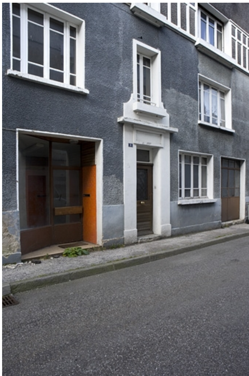
Baies du rez-de-chaussée et du premier étage.
