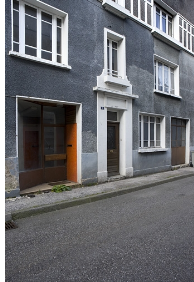
Baies du rez-de-chaussée et du premier étage. Phot. Yves Sancey IVR43_20093900138NUC2A
