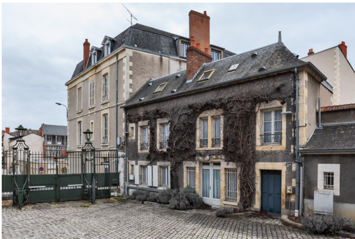
Façade sur la cour.
