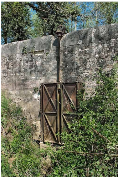
Vanne de l'aqueduc ménagé dans la route-digue.
