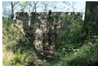
Vanne de l'aqueduc.
