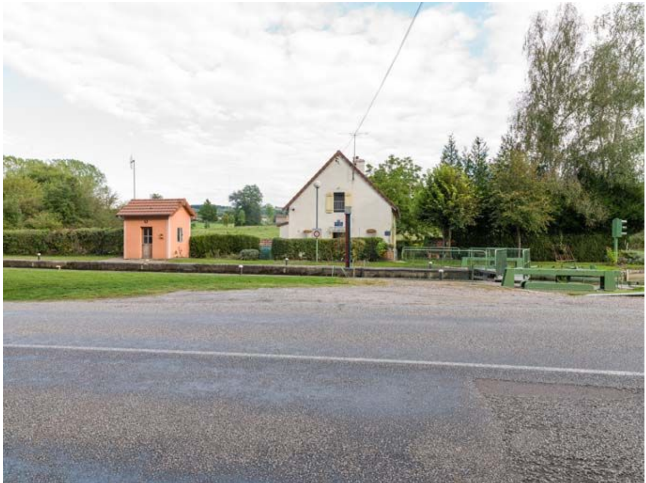
Vue d'ensemble du site d'écluse.
