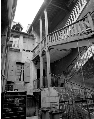
L'escalier s'ouvrant sur la cour. Phot. Yves Sancey IVR43_19833900274X
