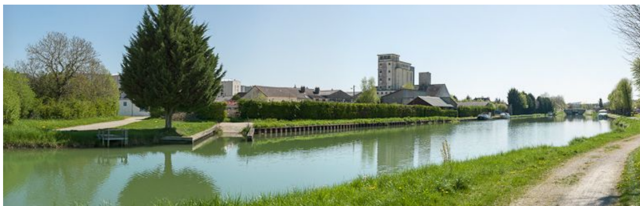
Le port vu d'aval.
