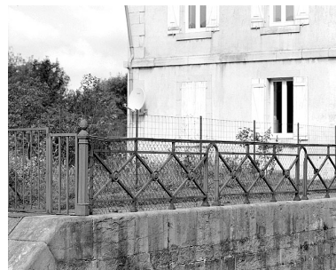
Garde-corps métallique. Phot. Jérôme Mongreville IVR43_20032500138X
