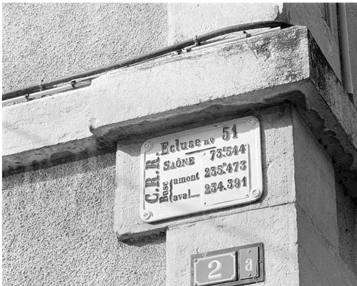
Plaque d'identification de l'écluse.
