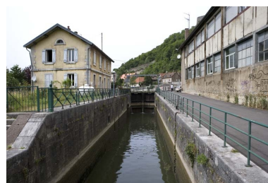
Intérieur du sas, depuis l'aval. Phot. Yves Sancey IVR43_20062500292NUCA
