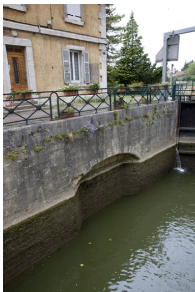
Emplacement de l'ancien vantail amont, dans le bajoyer droit. Phot. Yves Sancey IVR43_20062500284NUCA
