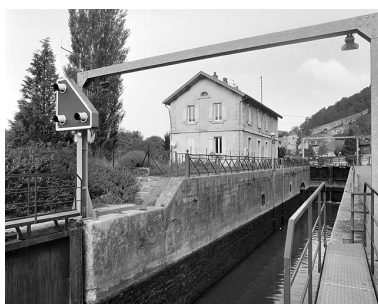
Intérieur du sas, de trois quarts. Phot. Jérôme Mongreville IVR43_20032500137X
