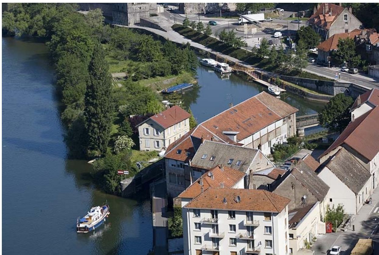
Vue d'ensemble plongeante, depuis l'aval.
