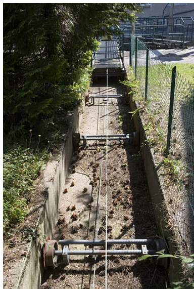
Système d'entraînement de la passerelle. Phot. Yves Sancey IVR43_20062500219NUCA
