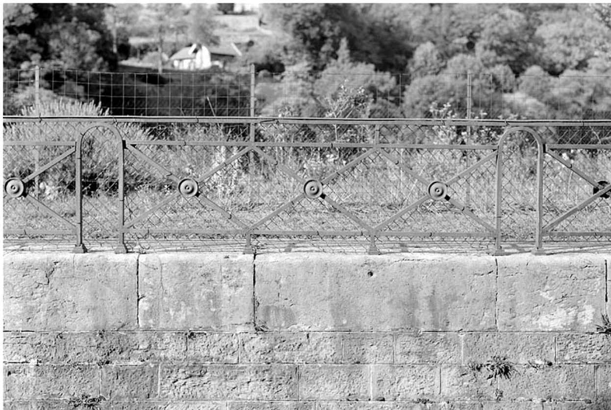
Garde-corps métallique, vu de face.
